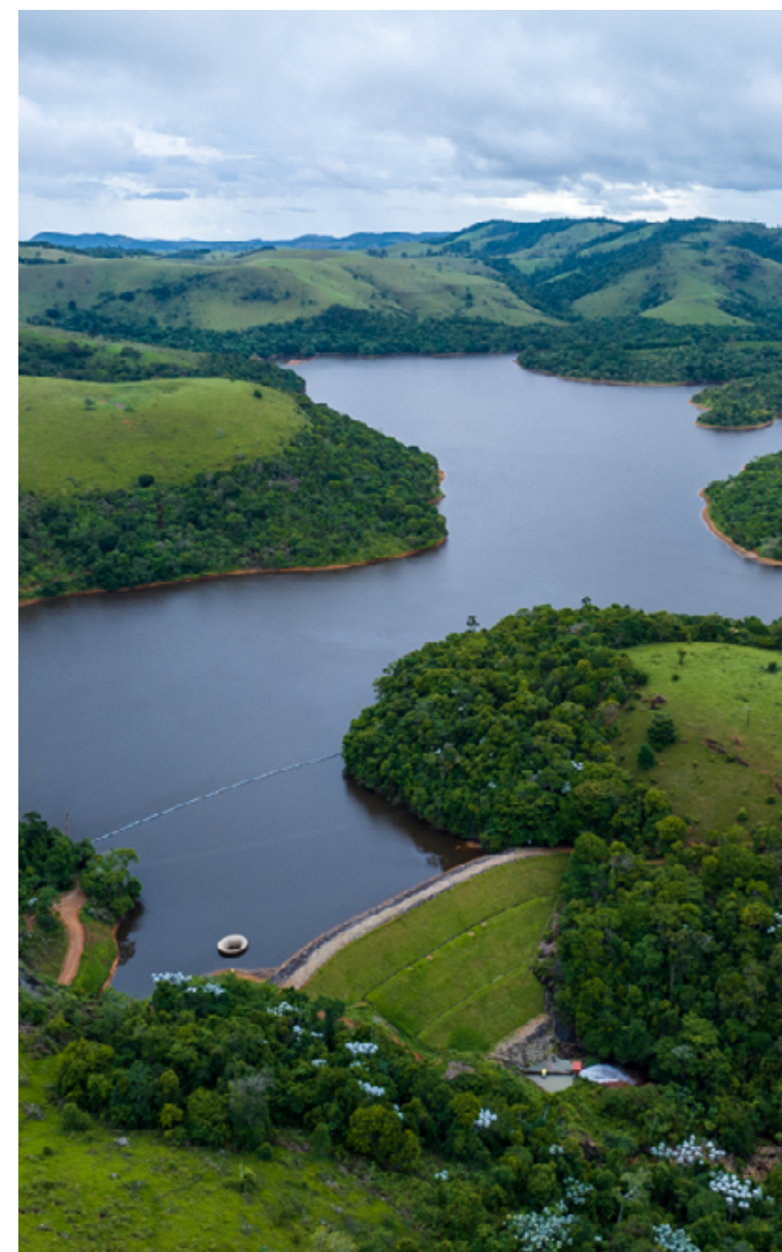
Reservatório da PCH Colino II · ESPRA (BA)
