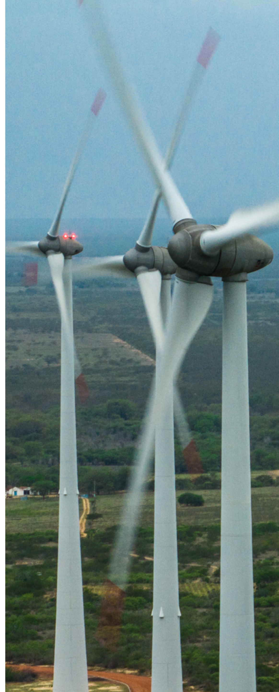
Parque Eólico Mangue Seco 3, Guamaré (RN)
