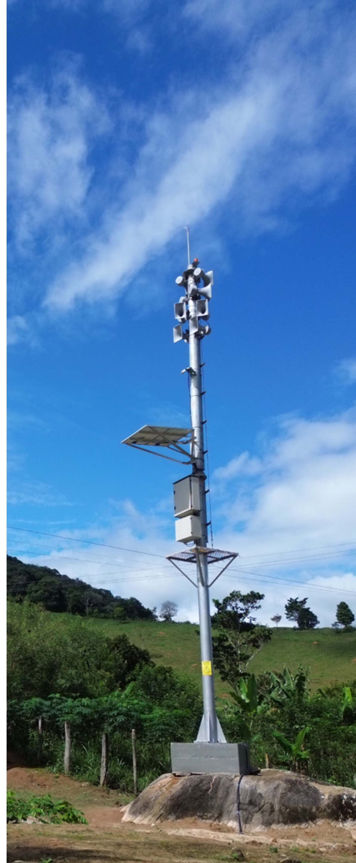
Torre de comunicação com sirene de alerta integrado (PAE)
