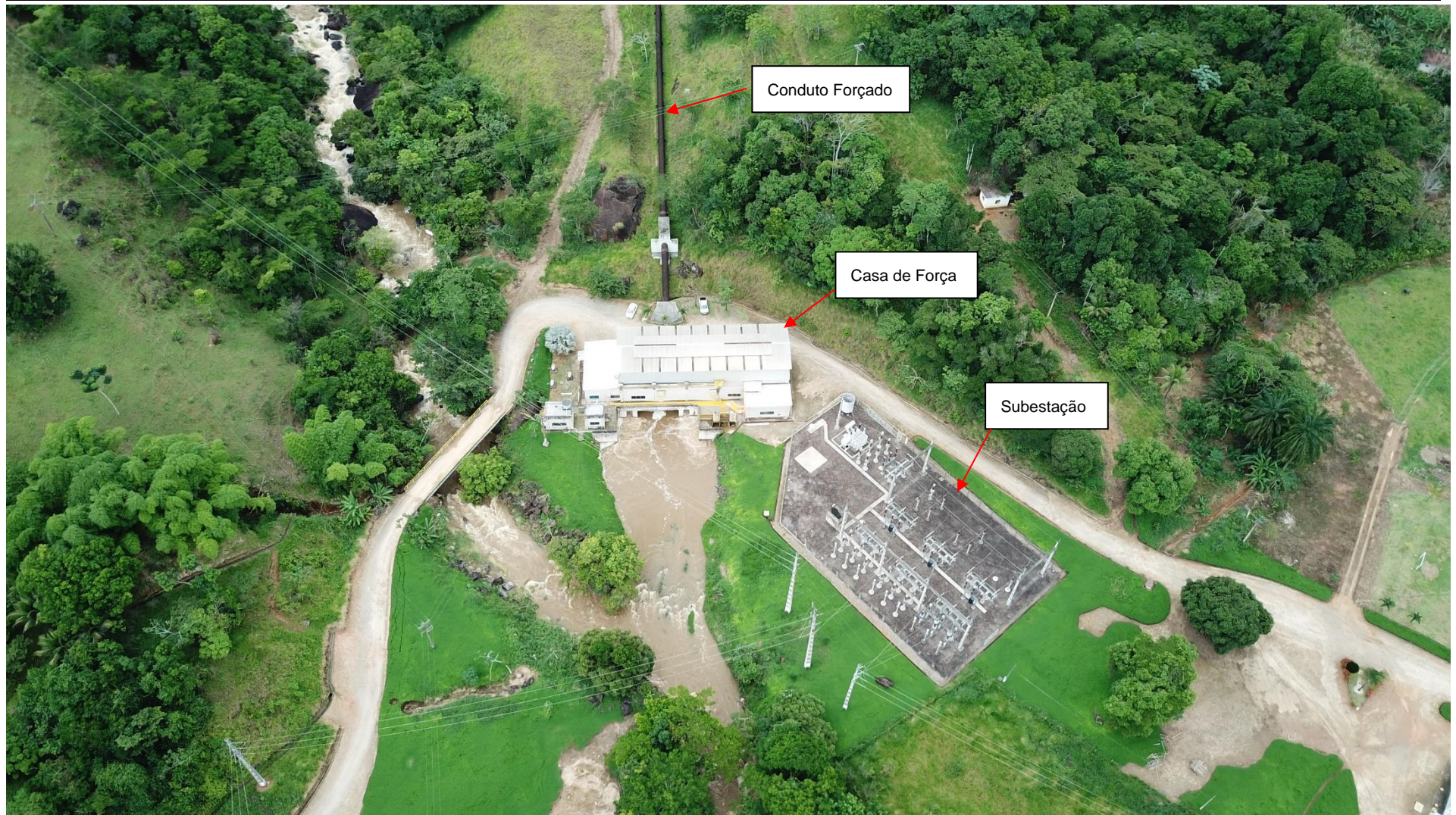
Figura 2 – Jusante da PCH Cachoeira da Lixa
