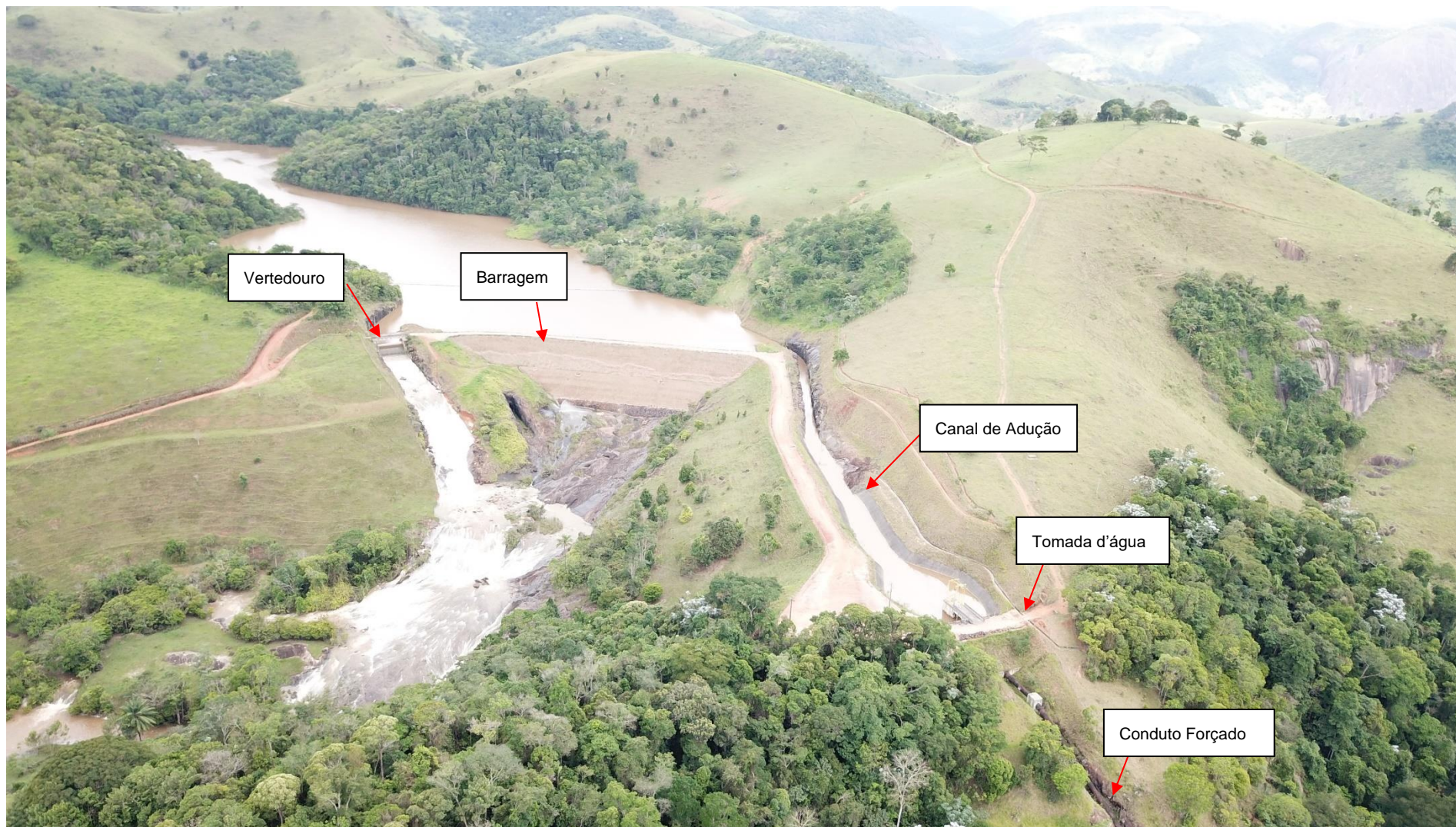
Figura 1 – Montante da PCH Cachoeira da Lixa
