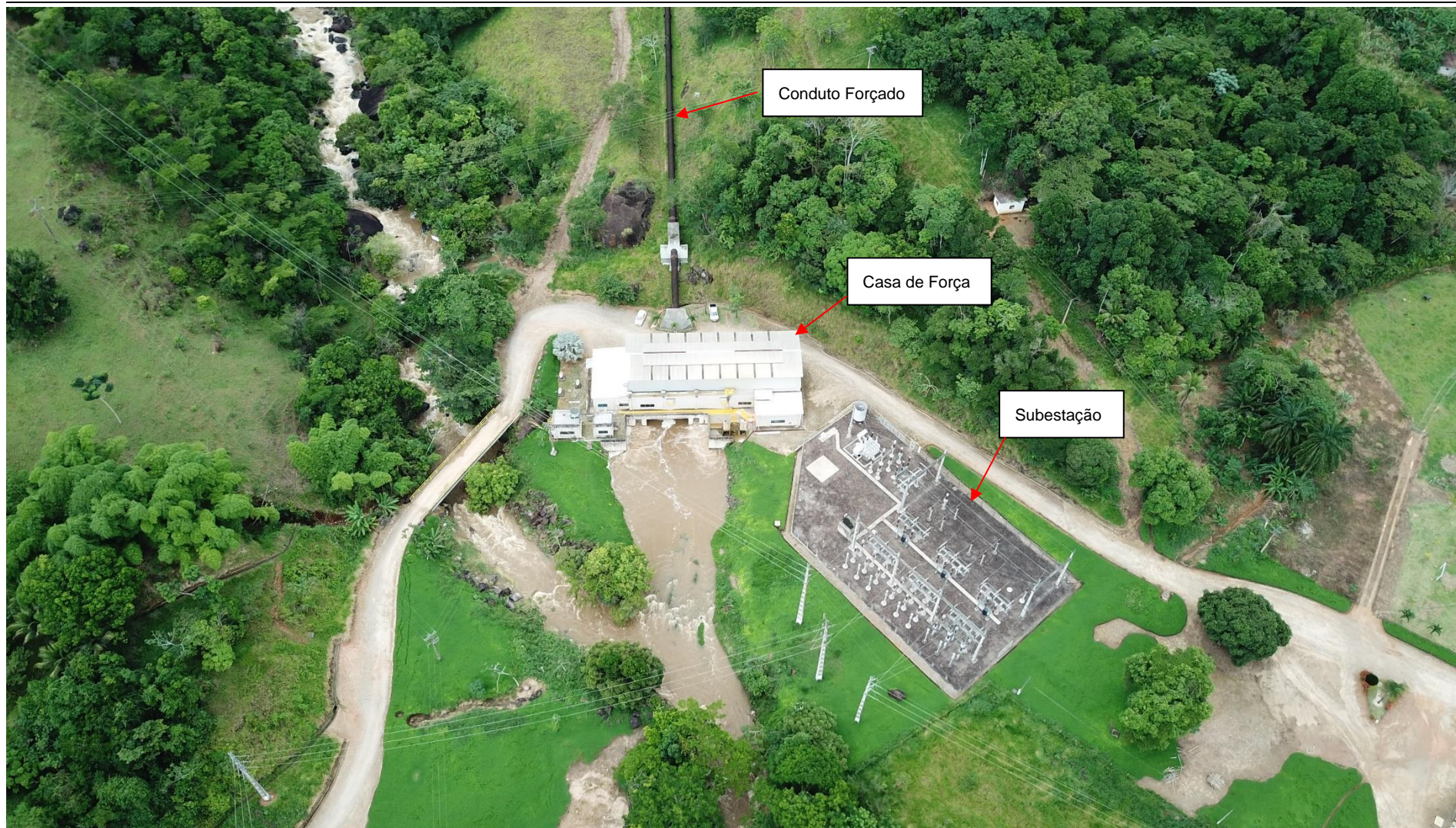
Figura 2 – Jusante da PCH Cachoeira da Lixa
