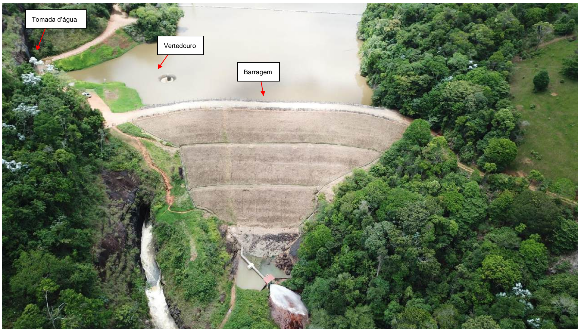
Figura 1 – Montante da PCH Colino 2
