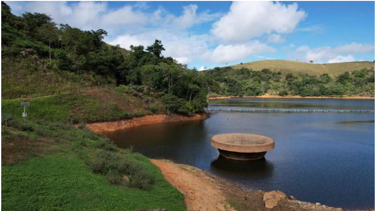
Figura 26 – Vertedouro da PCH Colino 2
