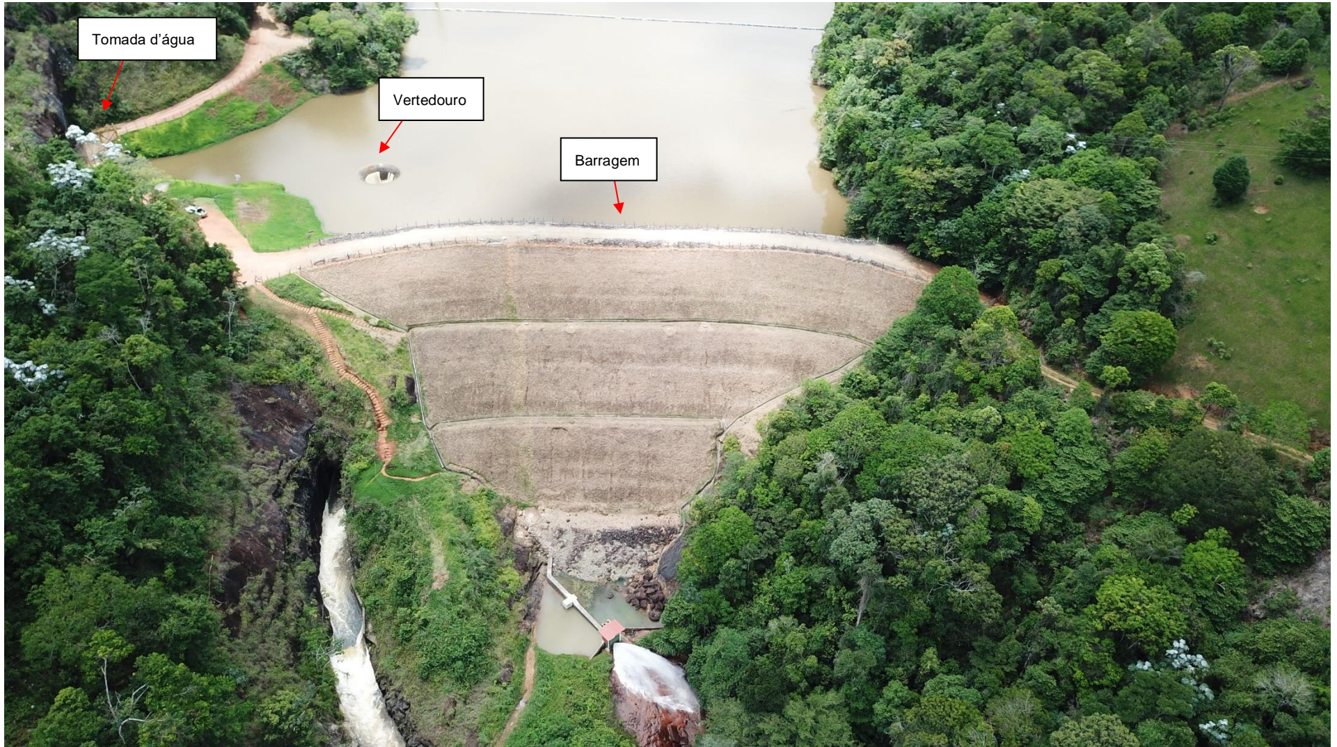
Figura 1 – Montante da PCH Colino 2
