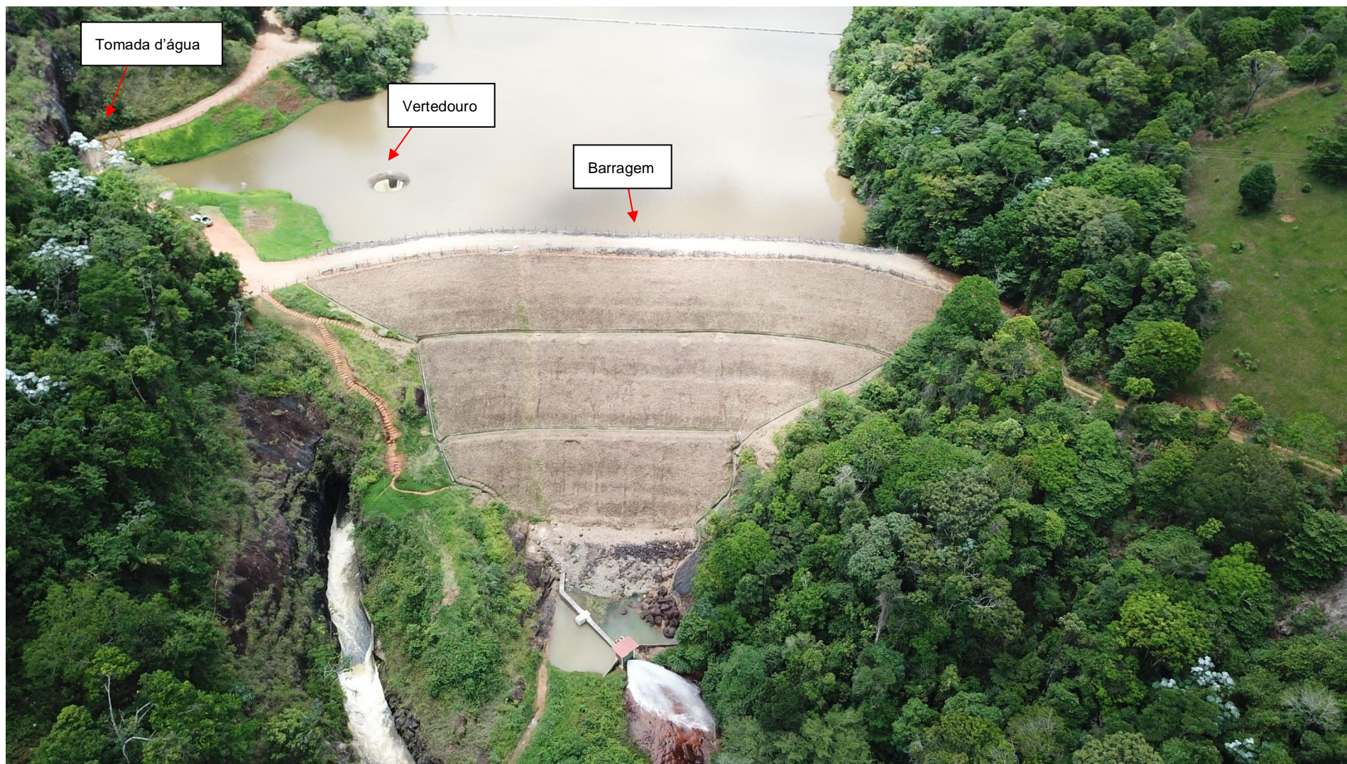
Figura 1 – Montante da PCH Colino 2
