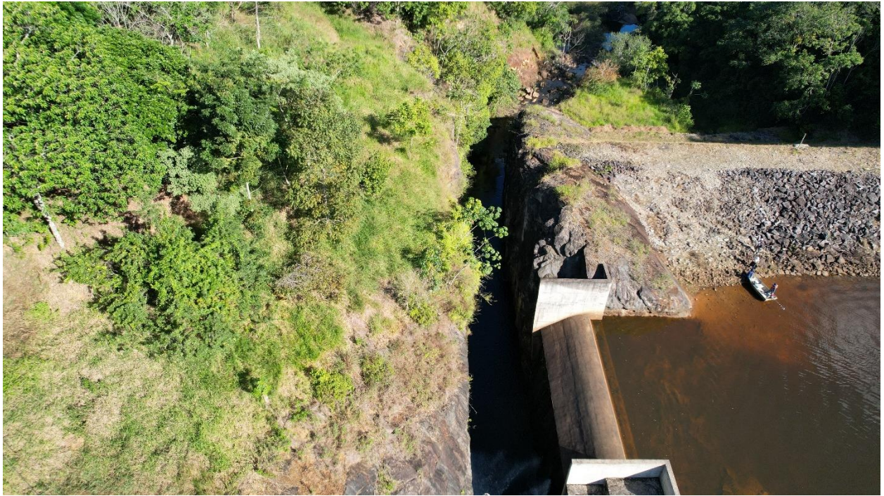
Figura 23 – Vertedouro da PCH Colino 1
