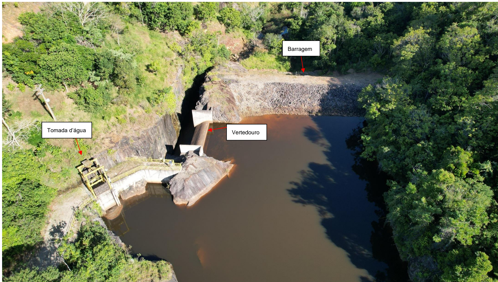
Figura 1 – Montante da PCH Colino 1
